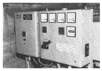
Fig. 3: Boîtier de commande fixé à l'agrégat, avec instruments indicateurs et interrupteur principal.
