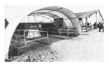
Fig. 4: L'Exposition secondaire consacrée aux étables de prix avantageux pour bovins a montré qu'il est possible de réaliser de telles constructions de façon rationnelle tout en dépensant bien moins. A relever qu'une grande partie de la construction peut être exécutée par l'agriculteur lui-même ou un groupe d'agriculteurs. L'étable que l'on voit au premier plan et qui est recouverte d'une feuille de plastique revient à 850 marks la stalle.
