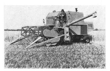
Diesel d'une puissance de 50 ch (34 kW). Son équipement standard comporte notamment un système de direction, des dispositifs hydrauliques pour régler la hauteur de coupe et la hauteur du rabatteur, des diviseurs d'épis en trois parties et des releveurs d'épis en acier à ressorts.
