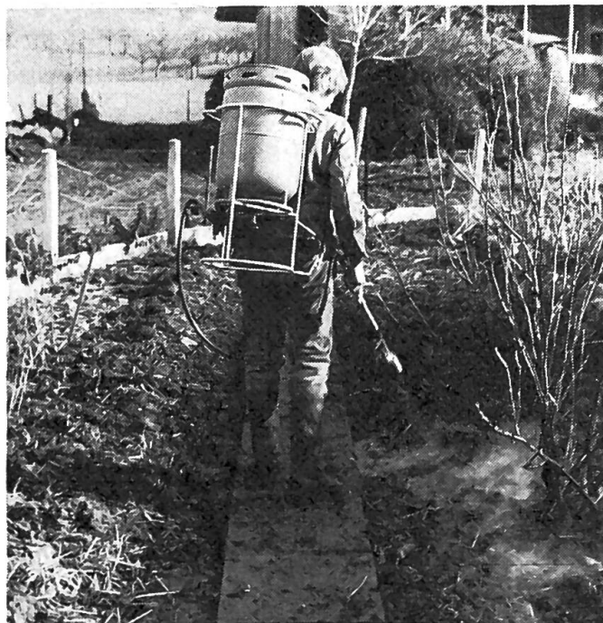
Fig.1: Aspect de l'exécution à dos de l'appareil utilisé pour la destruction thermique (par air chaud) des mauvaises herbes. Cette exécution convient plus spécialement pour les surfaces réduites, les terrains en pente, les serres, les chemins et les places.
