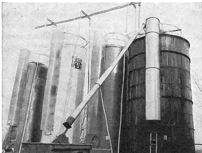
Fig. 4: Rail de grue monté au-dessus d'une batterie de quatre silos à fourrage. Ce rail sert à mettre en place la désileuse par le haut et à la transférer d'un silo à l'autre. Prix de l'installation (désileuse comprise): Fr. 16 000.—.
