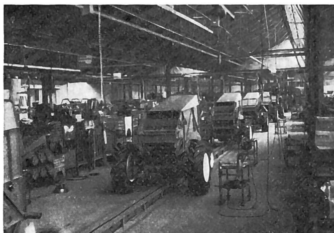
Fig. 2: Une imposante chaîne de production permet à environ 4000 moissonneuses-batteuses «Fahr» de sortir d'usine chaque année. Leur fabrication a lieu dans les anciennes halles de l'entreprise Ködel & Böhm.
