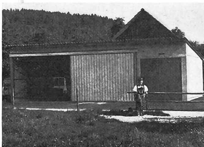
Fig. 4: Garage spacieux pour les tracteurs et les machines agricoles. Il a été construit selon le système de l'assemblage d'éléments préfabriqués. On peut y entreposer même les tracteurs avec arceau de sécurité, les machines effectuant la récolte totale de certains produits et les hautes autochargeuses auto-tractées à fourrages. Remise à l'agriculteur clés en main.
