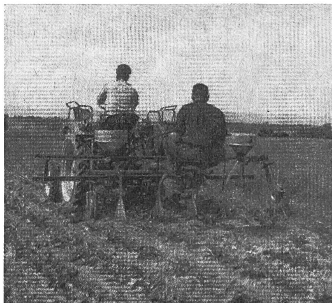
Fig. 5: Machine spécialement construite pour l'épandage des granulés. Elle est maniable, peut être facilement montée sur l'équipement de base de tout instrument universel de culture et offre la possibilité d'épandre de façon irréprochable à bonne allure. Elle convient aussi très bien pour une utilisation collective.
