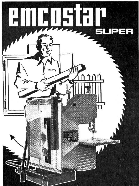
Vous travaillez vraiment comme un menuisier avec la nouvelle machine universelle à travailler le bois EMCOSTAR-SUPER. Sans longue transformation, par manipulation d'un levier, vous pouvez: scier au ruban et en circulaire, poncer avec disque, rainurer et réaliser les cannelures. En équipements complémentaires vous obtenez les appareils à mortaiser, fraiser, tourner etc. et encore la raboteuse-dégauchisseuse EMCOREX B-20, mobile, petite mais de haute performance. Faites le menuisier vous-même.
