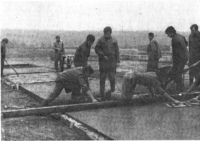
Fig. 3: Bétonnage du passage de service d'une grange avant la construction de cette dernière.
