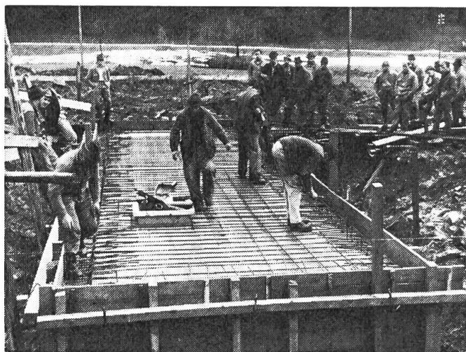
Fig. 2: Initiation à la pose d'une armature de béton.
