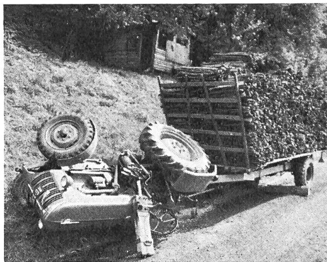
Fig. 6: En actionnant brusquement le levier du frein de remorque, lequel levier se trouve ici sur le timon de cette dernière, le conducteur du tracteur a provoqué le renversement de sa machine à la suite de la violente poussée exercée par la remorque.
