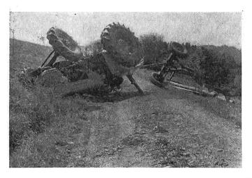
Fig. 2: Une remorque vide a fait déraper le tracteur – il s'agit pourtant d'une machine à quatre roues motrices – sur un accident de terrain.
