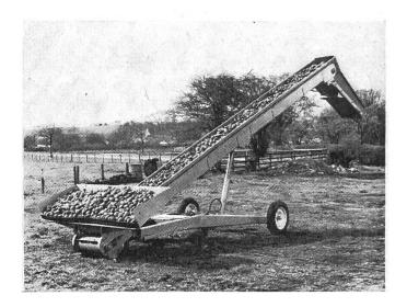
Aspect du nouveau matériel de manutention de fabrication anglaise pour les pommes de terre. — Il s'agit d'un élévateur à ruban sans fin qui peut être actionné aussi bien par un moteur électrique que par un moteur à explosion.
