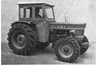
Cadre de sécurité muni d'un toit et d'un pare-brise relevable (en haut). — On peut aussi l'équiper de panneaux pour en faire une cabine de sécurité.
