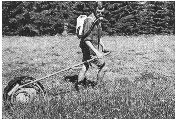
Fig. 4: De la propagande a été également faite auprès des paysans de montagne au sujet de cette motofaucheuse monoroue. Etant donné la faible surface qu'on arrive à récolter à l'heure avec elle et aussi l'insuffisance de ses aptitudes pour un emploi sur les terrains en pente, elle ne peut pas entrer en considération. Son conducteur a été équipé ici d'un appareil destiné à mesurer l'énergie qu'il lui faut dépenser pour faucher avec cette machine.
