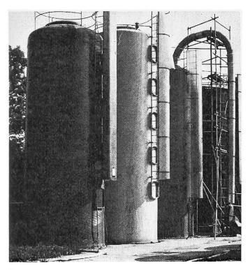
Fig. 8: Silos à fourrages verts et préfanés construits avec des éléments en matière plastique renforcée par des fibres de verre. Ce matériau a été fabriqué selon les méthodes suivantes (de gauche à droite): par enroulage de stratifils, par injection (projection), par enroulage de rubans.
