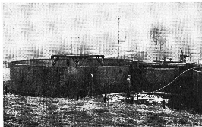
Fig. 10: Cuves pour eaux usées en matière synthétique armée de verre, avec système de ventilation.
