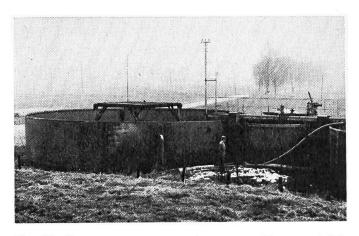
Fig. 10: Cuves pour eaux usées en matière synthétique armée de verre, avec système de ventilation.
