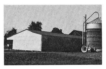
Fig. 3: Halle en tuyaux d'acier recouverte de feuilles en matière plastique.
