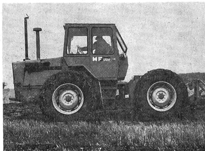
Fig. 3: Aspect d'un tracteur Massey-Ferguson de conception ultra-moderne. Il s'agit du modèle 1200, dont le moteur Diesel développe une puissance supérieure à 150 ch.
