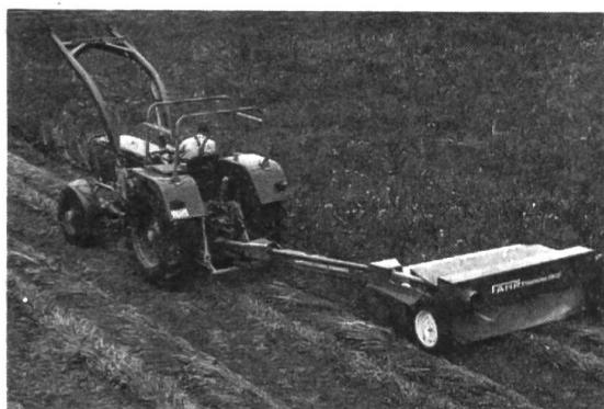
Depuis son apparition sur le marché, le matériel de conception moderne que représente la faucheuse rotative à tambours à lames a connu un succès sans cesse croissant. La Fabrique de machines FAHR S.A., à Gottmadingen (Allemagne), a réalisé récemment une nouvelle faucheuse de ce genre, du type tiré, spécialement des-
