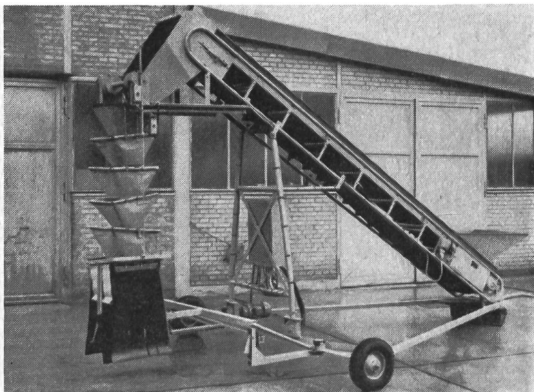
Fig. 12: Dispositif Jabelmann réalisé pour le remplissage de harasses surdimensionnées à la ferme ou à l'entrepôt. — Un élévateur à ruban de caoutchouc et éléments entraîneurs amène les tubercules jusqu'à une goulotte de déversement d'où ces derniers tombent dans une série d'entonnoirs en toile à voile servant d'amortisseurs de chocs. Ces entonnoirs se relèvent progressivement — grâce à l'action de cellules photo-électriques — au fur et à mesure que la harasse se remplit.
