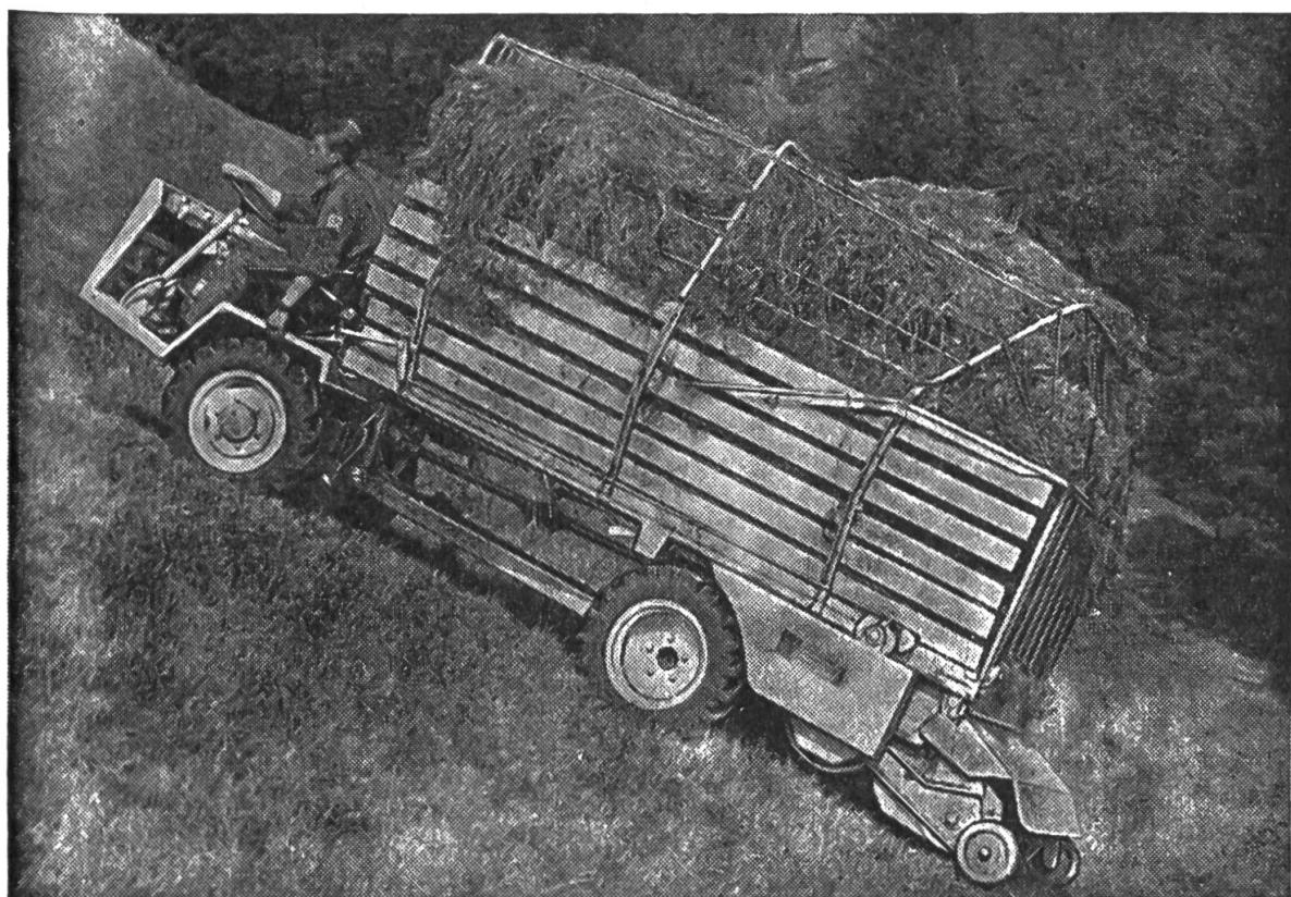
L'autochargeuse automotrice ALPINISTE est un véhicule universel qui se rit des pentes les plus raides et accidentées dans l'agriculture alpine. Grâce à son excellente stabilité en pente, l'ALPINISTE se fait un jeu des côtes même supérieures à 60 %. Il a une capacité utile de 12 m<sup>3</sup>.
