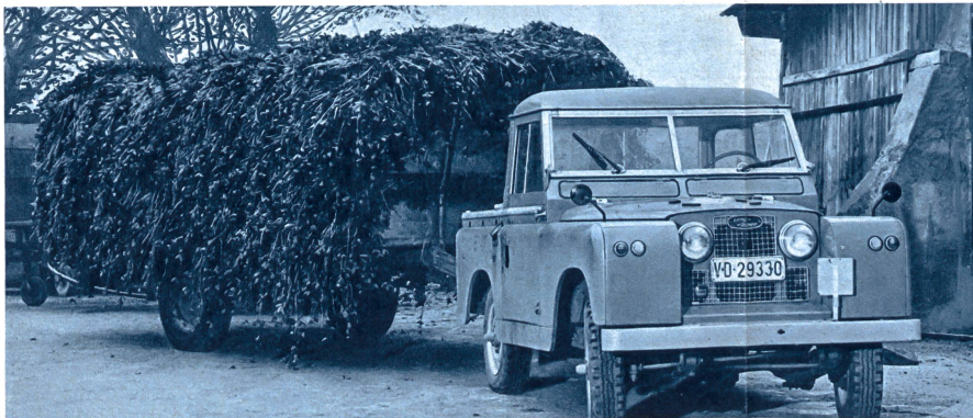
La Land-Rover tracte des remorques jusqu'à 5 tonnes
