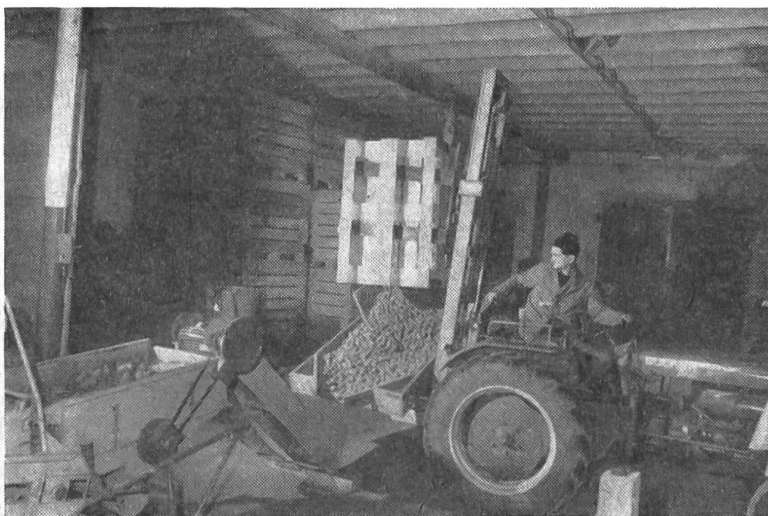
Fig. 11: Vider le contenu des caisses-palettes directement sur le ruban d'alimentation du trieur-calibreur permet d'augmenter le rendement du travail effectué avec une telle machine. Pour cela, il est toutefois indispensable qu'une trémie de remplissage de dimensions suffisamment grandes soit montée à l'extrémité du ruban d'alimentation.
