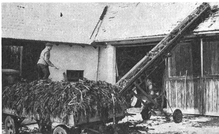
Fig. 5: Transporteur-élévateur à chaînes avec éléments entraîneurs à griffes employé pour mettre des feuilles de betteraves en silo. Ce matériel polyvalent, également utilisable pour l'ensilage du maïs-fourrage, travaille en mouvement continu et à vitesse réduite. Il suffit d'une faible puissance pour l'actionner. Les frais de réparation et d'entretien qu'il exige sont minimes.
