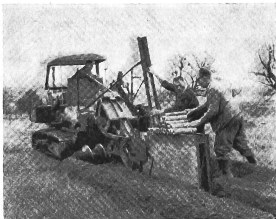
Aspect de la nouvelle fraise à creuser les tranchées et à poser les tuyaux (drains, conduites à câbles ou à eau, etc.). Les tuyaux en matière plastique qu'on voit ici sont en chlorure de polyvinyle (PVC).
