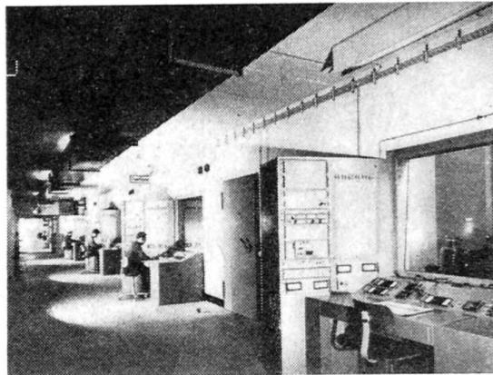
Les cabines de contrôle pour les moteurs Diesel refroidis par air représentent les toutes dernières réalisations de la technique moderne. Ces cabines, équipées chacune d'un pupitre de commande à l'extérieur, contiennent des instruments de mesure qui fournissent de précieuses indications.
