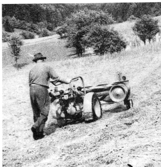
Tracteur à 2 roues de construction solide accouplé à un râteau-faneur frontal du type à chaînes.
