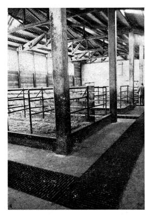
Fig. 5: Aspect de l'aire de couchage avec ses logettes. Les caniveaux d'évacuation des déjections par voie hydraulique sont recouverts de grilles.
