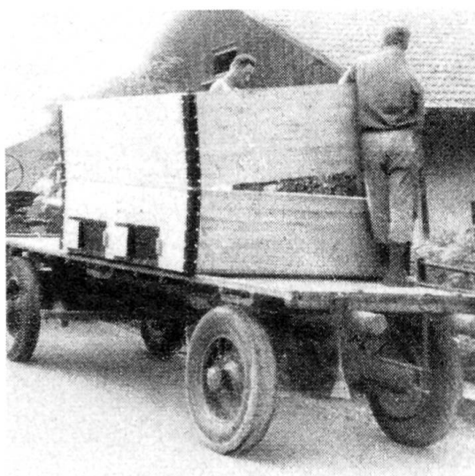
Ajustage par emboîtement de l'élément supérieur (cadre), qui est parfaitement étanche et ne peut glisser.
