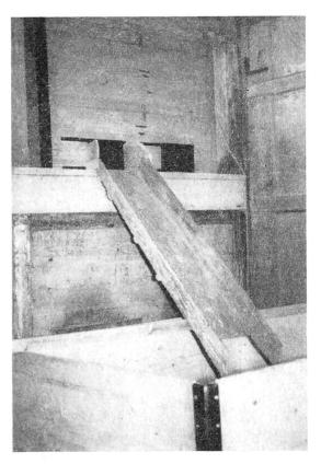
Le devant du silo vu d'en bas. Il suffit de faire glisser latéralement les vannes pour que la masse de grain, de plusieurs tonnes, se déverse sur le char et soit prête à être transportée jusqu'au lieu de livraison.
