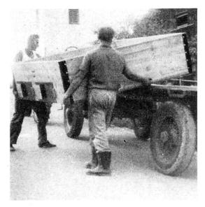
Mise en place de l'élément inférieur du bac (base) sur le char.
