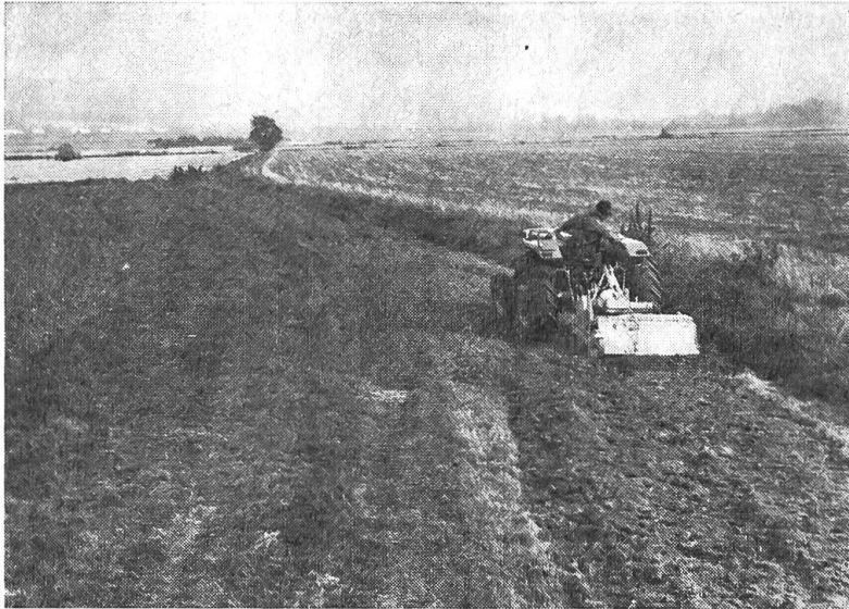
Fig. 1: Mise en service de la herse rotative à prise de force, sur une longue bande étroite en plein champ, en vue de créer un chemin d'exploitation. La herse ameublit la couche de terre arable afin qu'elle puisse être débarrassée par la lame niveleuse et évacuée par le chargeur frontal. Le sol sera alors consolidé grâce au procédé dit de la stabilisation.
