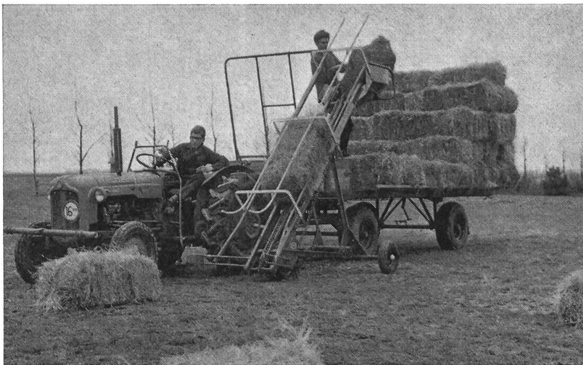
Fig. 15: Le nouveau chargeur de balles «Vicon», machine fonctionnant semi-automatiquement, permet d'alléger considérablement l'opération du chargement.
