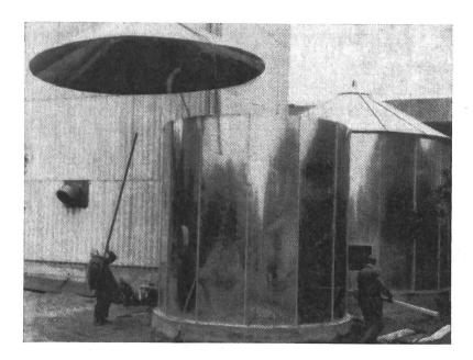
Au premier plan, on distingue un de ces nouveaux silos formés de tôles d'aluminium lisses assemblées au moyen de brides spéciales, que deux hommes sont en train de monter. La toiture, conique, est aussi faite d'éléments semblables. Le silo de type nouveau que l'on voit à l'arrière plan, à droite, se trouve prêt à l'emploi.
