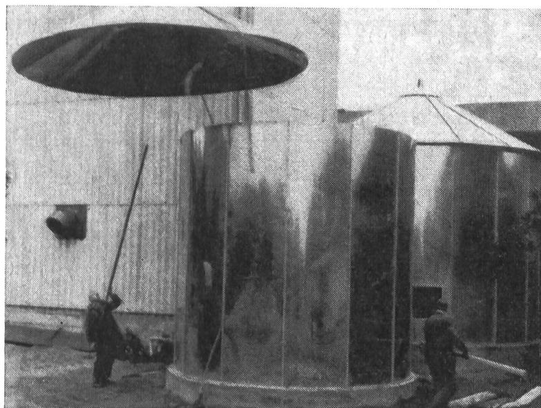
Au premier plan, on distingue un de ces nouveaux silos formés de tôles d'aluminium lisses assemblées au moyen de brides spéciales, que deux hommes sont en train de monter. La toiture, conique, est aussi faite d'éléments semblables. Le silo de type nouveau que l'on voit à l'arrière plan, à droite, se trouve prêt à l'emploi.
