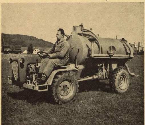
La citerne d'aspiration et de compression permet d'épandre l'engrais en réalisant une grande économie de travail. Ce matériel, que l'on peut monter dorénavant sur le Pullax, vient fort utilement compléter la gamme d'outils prévus.
