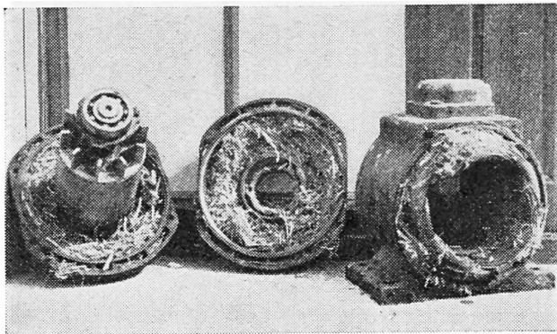
Fig. 5 Les moteurs ouverts se remplissent par contre très facilement de toutes sortes d'impuretés.
