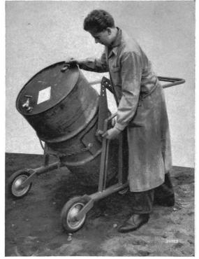
Quand on veut vider un fût plein, il faut tirer la cheville d'arrêt vers l'extérieur et faire pencher légèrement le fût (fig. 2). Lorsqu'il est en position horizontale, la cheville d'arrêt se rengage d'elle-même dans le trou correspondant et l'on peut à ce moment-là soutirer le liquide ou bien
