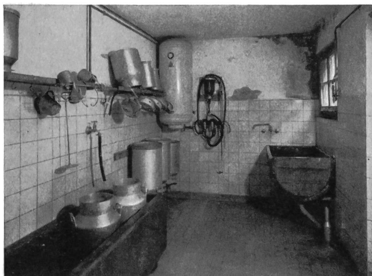
Fig. 10: Dans ce cas, on n'a pas voué suffisamment d'attention à l'aération et à l'isolation du local. Des carreaux de faïence contre les parois ne suppriment pas les causes d'une humidité excessive.
