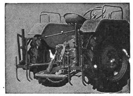
Pour l'attelage trois-points, il existe un modèle DEGENHART éprouvé à 2 leviers, coûtant 270.ou 300 fr., qui est indépendant de la barre d'attelage et de la timonerie du relevage hydraulique.
