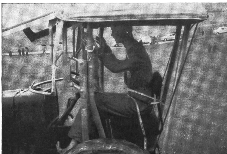
Fig. 4: Tracteur sur lequel a été installé un mannequin avant de procéder aux démonstrations. Il fut constaté, également dans ce cas, que ni le toit-abri ni le mannequin n'ont subi de dommages appréciables. (Cette photo permet de bien se rendre compte de l'extrême solidité du toit-abri, autrement dit de l'encadrement de pare-brise qui en forme l'ossature).
