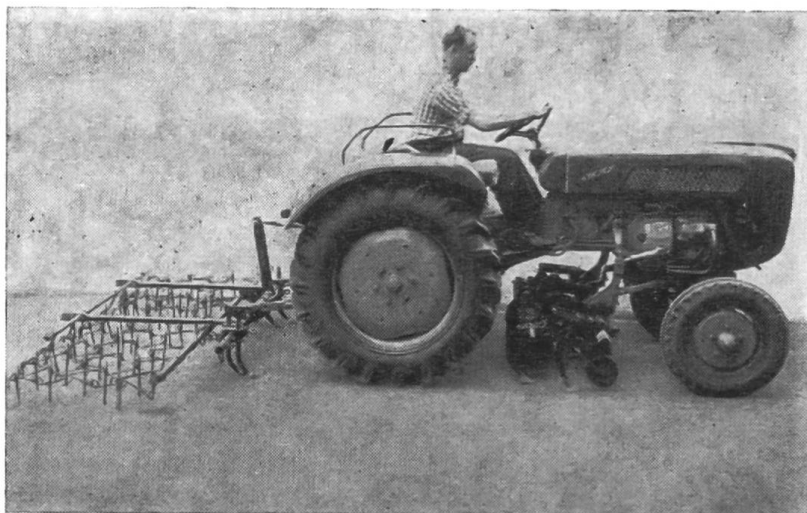
Fig. 12 Tracteur équipé d'une herse articulée et d'un cadre porte-outils (re- levable hydraulique- ment) pour l'entretien des cultures de better- aves
