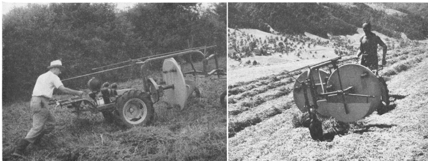
Fig. 1a et 1b: Machine de fanage à tambour oblique supportée par une et deux roulettes d'appui (faneur Aebi).
