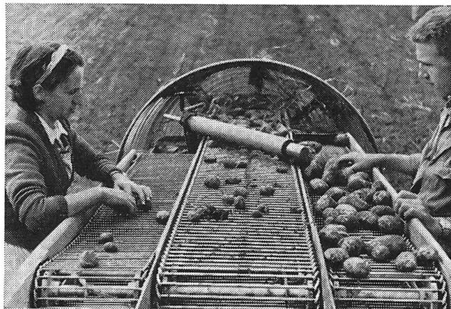
Pour la récolte des pommes de terre précoces, ou lors de conditions anormales, le rouleau pré-trieur est à enlever auparavant. Dans ce cas, les tubercules sont retirés directement du ruban transporteur médian par le personnel assis des deux côtés et déposés sur les rubans extérieurs menant au poste d'ensachage. Ce système permet d'obtenir des pommes de terre précoces prêtes pour la vente déjà à la sortie de la récolteuse SAMRO.
