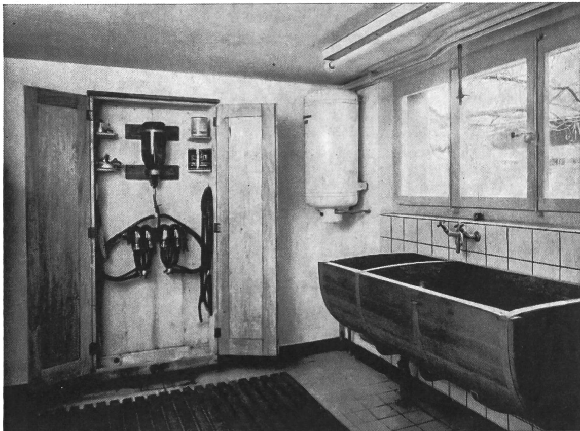
Fig. 8: En faisant l'acquisition d'une machine à traire, il faut également prévoir un local approprié que l'on équipera notamment d'un chauffe-eau et d'un bassin de lavage à deux compartiments.
