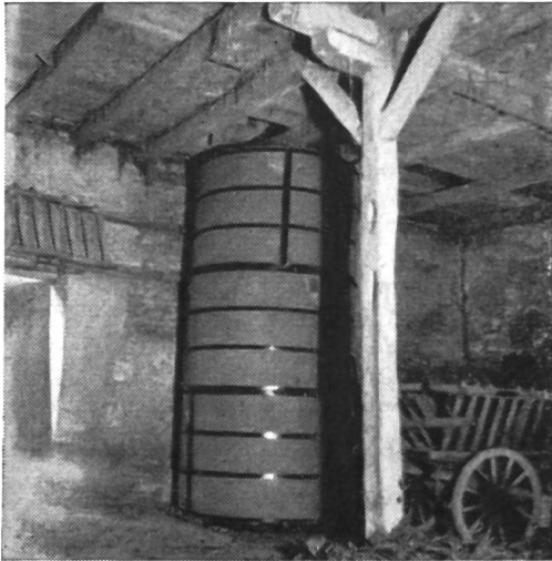
Fig. 3: Silo «Brisgau» installé dans une grange et formé de trois viroles assemblées et remplies au fur et à mesure de fourrage.
