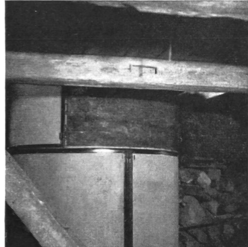
Fig. 4: Le désilage se montre très facile puisqu'il suffit d'enlever chaque élément l'un après l'autre.
