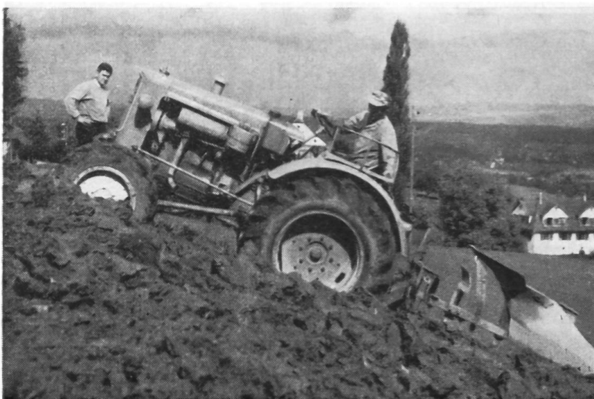
Fig. 3: Même vue que ci-dessus, mais prise de l'autre côté du tracteur. On y distingue mieux la profondeur du labour effectué (de 22 à 25 cm.).
