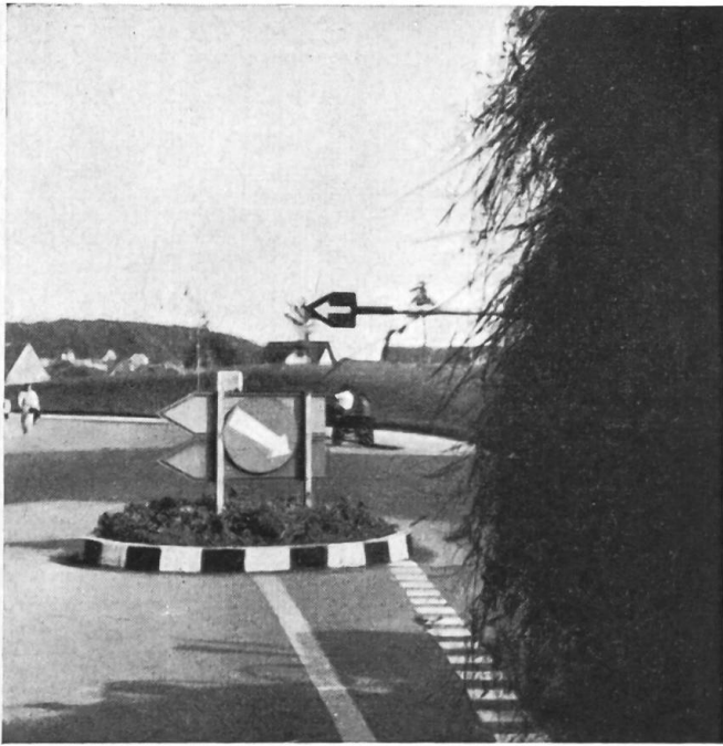
Fig. 4a: Palette de signalisation à long manche dépassant le char de récolte et parfaitement visible pour les usagers qui suivent.
