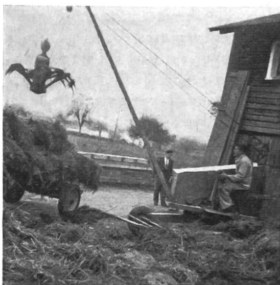
Fig. 4a et 4b: Grue à fumier du type mobile (1 homme de service).
