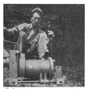
Les engrenages et les arbres doivent être pourvus de dispositifs de protection. Tous les leviers de commande (pour le freinage et l'embrayage) sont à aménager de telle façon qu'ils puissent être manœuvrés facilement, le corps restant dans une position commode. On évitera de combiner la commande de l'embrayage et du frein dans un seul levier.
