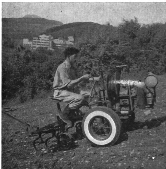
Fig. 4: L'«araignée» (avant-train autohaleur à roues non motrices) employée pour sarcler sur deux rangs en terrain fortement déclive (traction funiculaire à un seul homme de service).
