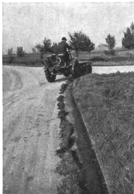
Fig. 2: Le dispositif rectifieur de bords de chaussées permet de travailler journellement une longueur de 8 km, alors que dans le même temps, un cantonnier, avec son coupe-bordure, n'arrive à approprier l'accotement que sur une distance de 400 à 600 m.
