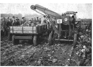
Fig. 2a et 2b: Les betteraves décrottées sont chargées par un élévateur sur une remorque à benne basculante roulant parallèlement à la récolteuse. Deux remorques sont prévues pour chaque machine de récolte, ce qui exige en tout 3 tracteurs (!). Les feuilles et collets sont laissés sur le sol car on ne cherche pas à les récupérer.
