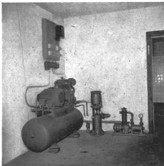
Fig. 8: Le coin des machines du local de graissage, où l'on voit le groupe compresseur d'air et les pompes de lavage. A l'extrême droite, la porte de communication avec la laverie.
