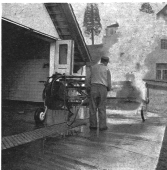
Fig. 4: L'emplacement extérieur de lavage, aménagé sur le devant de la STAMA. On distingue la grille d'écoulement pour la boue.
