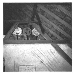
Fig. 8: Le coin des machines du local de graissage, où l'on voit le groupe compreseur d'air et les pompes de lavage. A l'extrême droite, la porte de communication avec la laverie.
